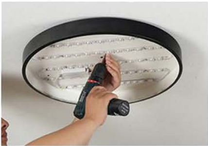
3. Fija los tornillos en los tacos.
